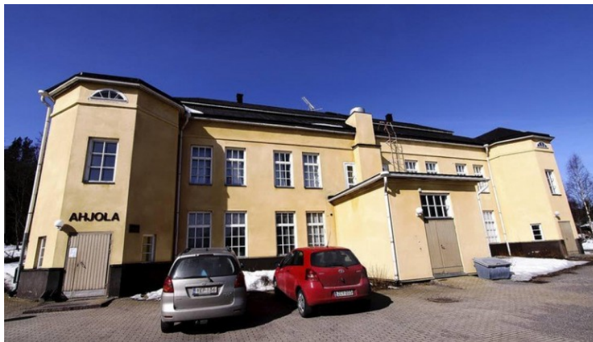
Vasemmasta ovesta sisään ja ylimpään kerrokseen.
